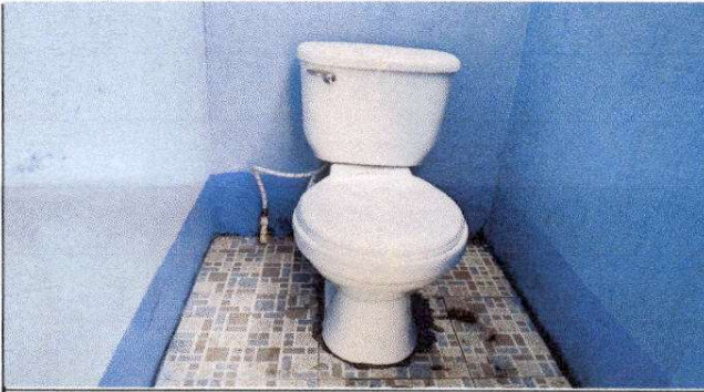
Foto 3: Instalación de taza de baño
