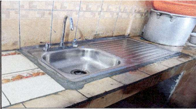
Foto1: Instalación de lavatrastos nuevo
