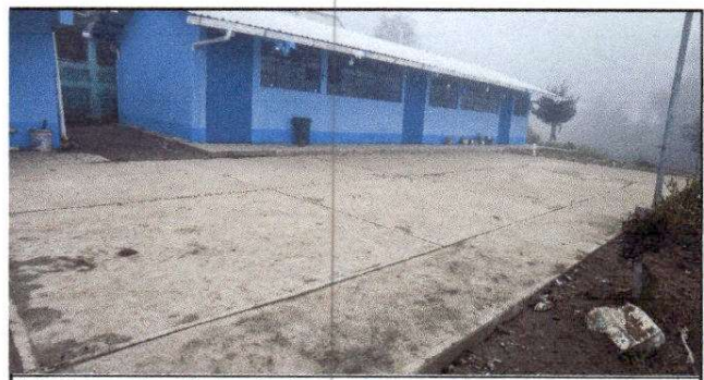
Foto 6: Losa de patio terminada
